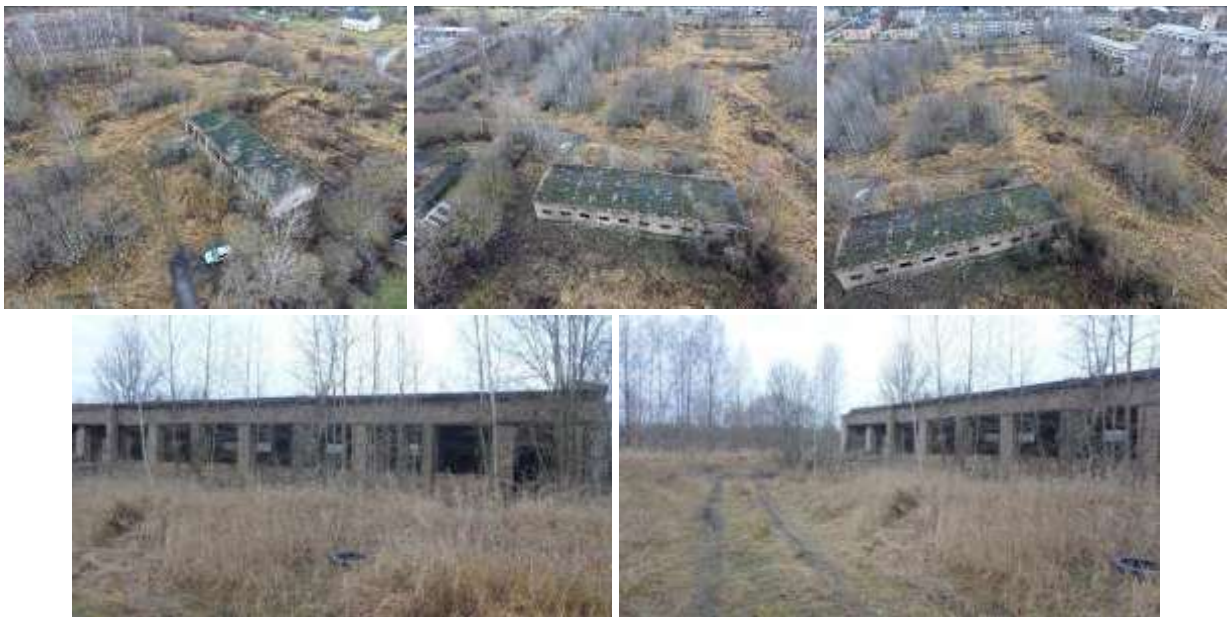
Nedzīvojamā ēka – ražošanas ēka ar kadastra apzīmējumu 7894 002 0093 008
